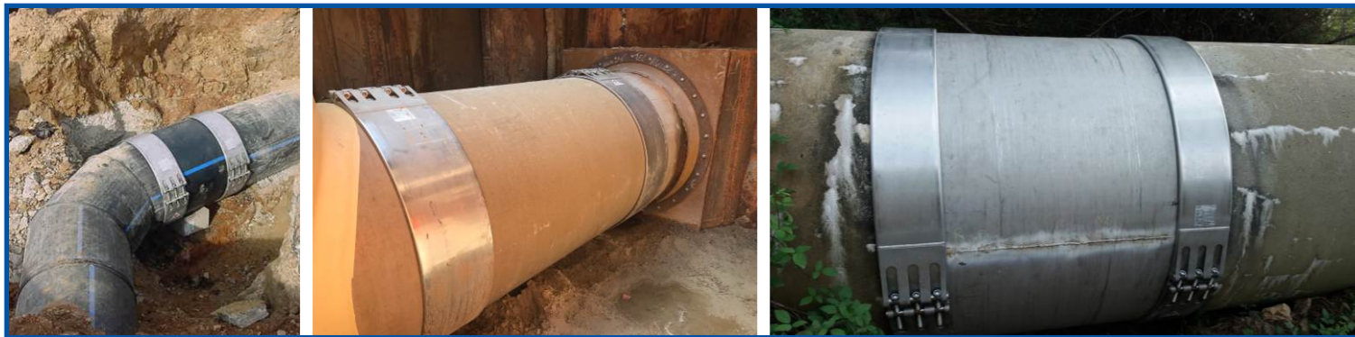
Popravak velikih oštećenja cijevi umetanjem zamjenske cijevi
